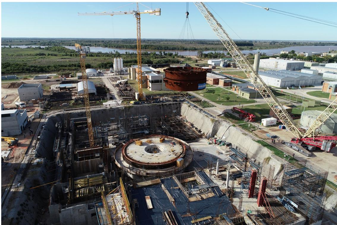
**Foto de tapa:** Maniobra de posicionamiento del Módulo 8 del liner de la contención del Edificio del Reactor, efectuada en abril de 2019. Casi debajo del Módulo 8 del liner se observa el hormigonado de la losa del nivel cero de la contención del reactor, uno de los hitos más relevantes del proceso constructivo del Edificio del Reactor, completado en marzo de 2019. Foto: © CNEA, abril de 2019.
