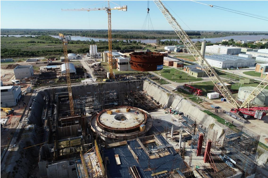
Maniobra de posicionamiento del Módulo 8 del liner de la contención del Edificio del Reactor en el Sitio CAREM, Predio CNEA, Complejo Nuclear Atucha. Foto: © CNEA, abril de 2019.
