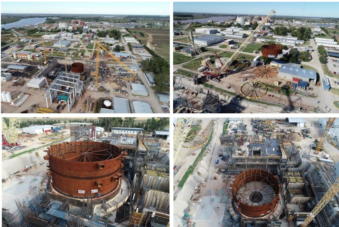
Diferentes vistas de las maniobras de posicionamiento del Módulo 8 del liner de la contención del Edificio del Reactor, Sitio CAREM, Precio CNEA, Complejo Nuclear Atucha. Fotos: © CNEA, abril de 2019.
